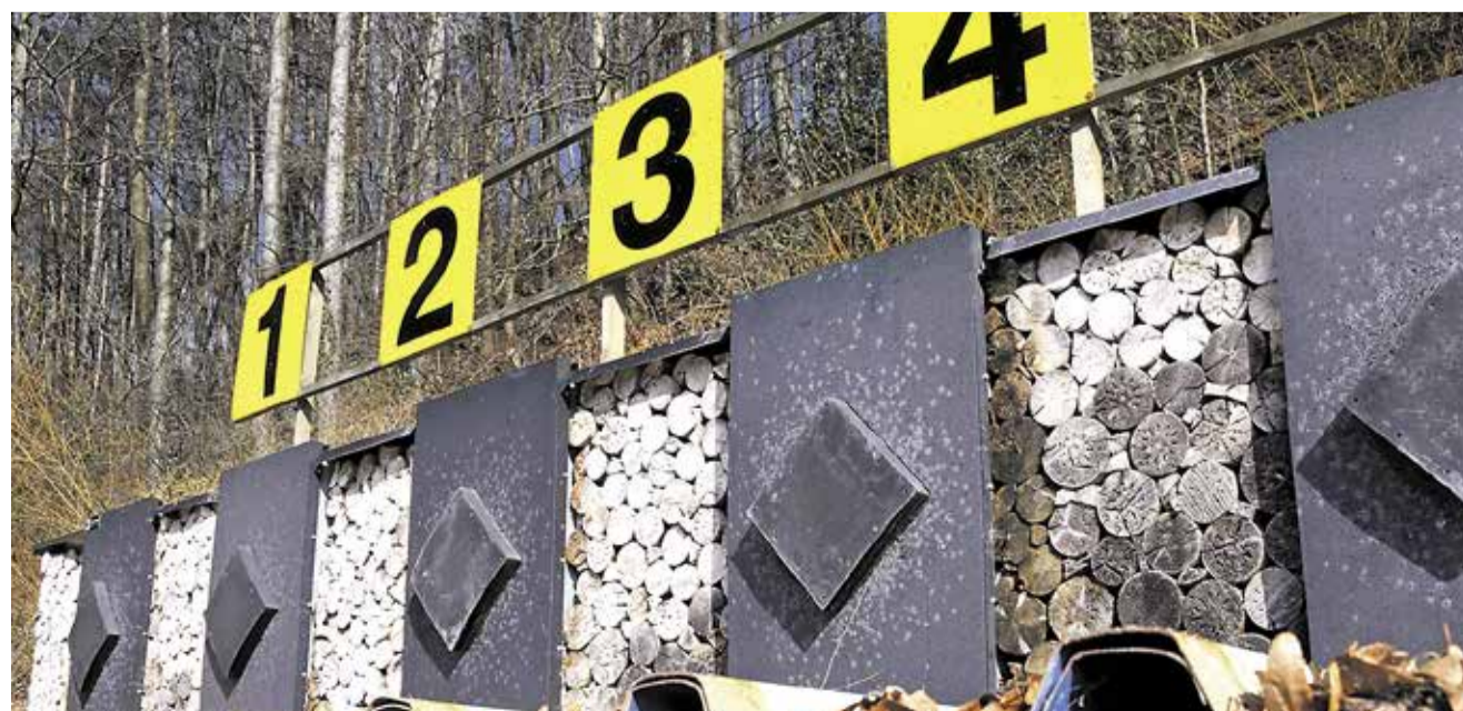
Blick aus dem Scheibenstand heraus auf den 2004 sanierten künstlichen Kugelfang für vier von gesamthaft acht Zielscheiben.
